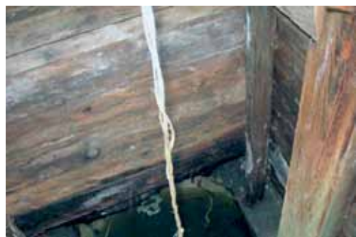
Комбинированная шахта колодца, п. Цимлянский. Фото автора
